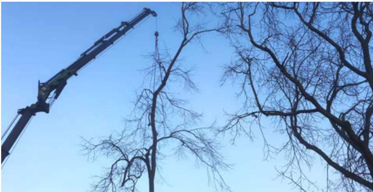
Illustration 5: "Skævt" løft af top med brug af støtteline. Begge kæder er dimensioneret til at kunne bære løftet hver for sig.
