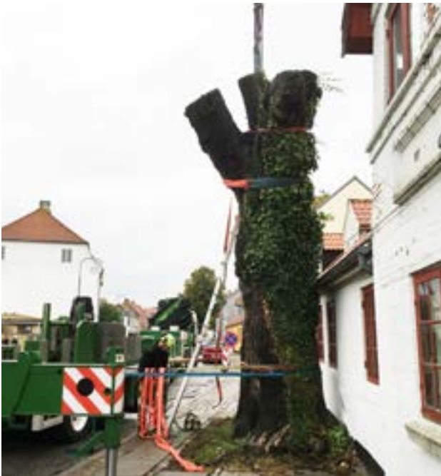
Illustration 9: Den store stamme står med få centimeters afstand til den gamle bygning. Basis er fikseret både med vandrette båndstrammere, samt et lige igennem snit med hylde.
