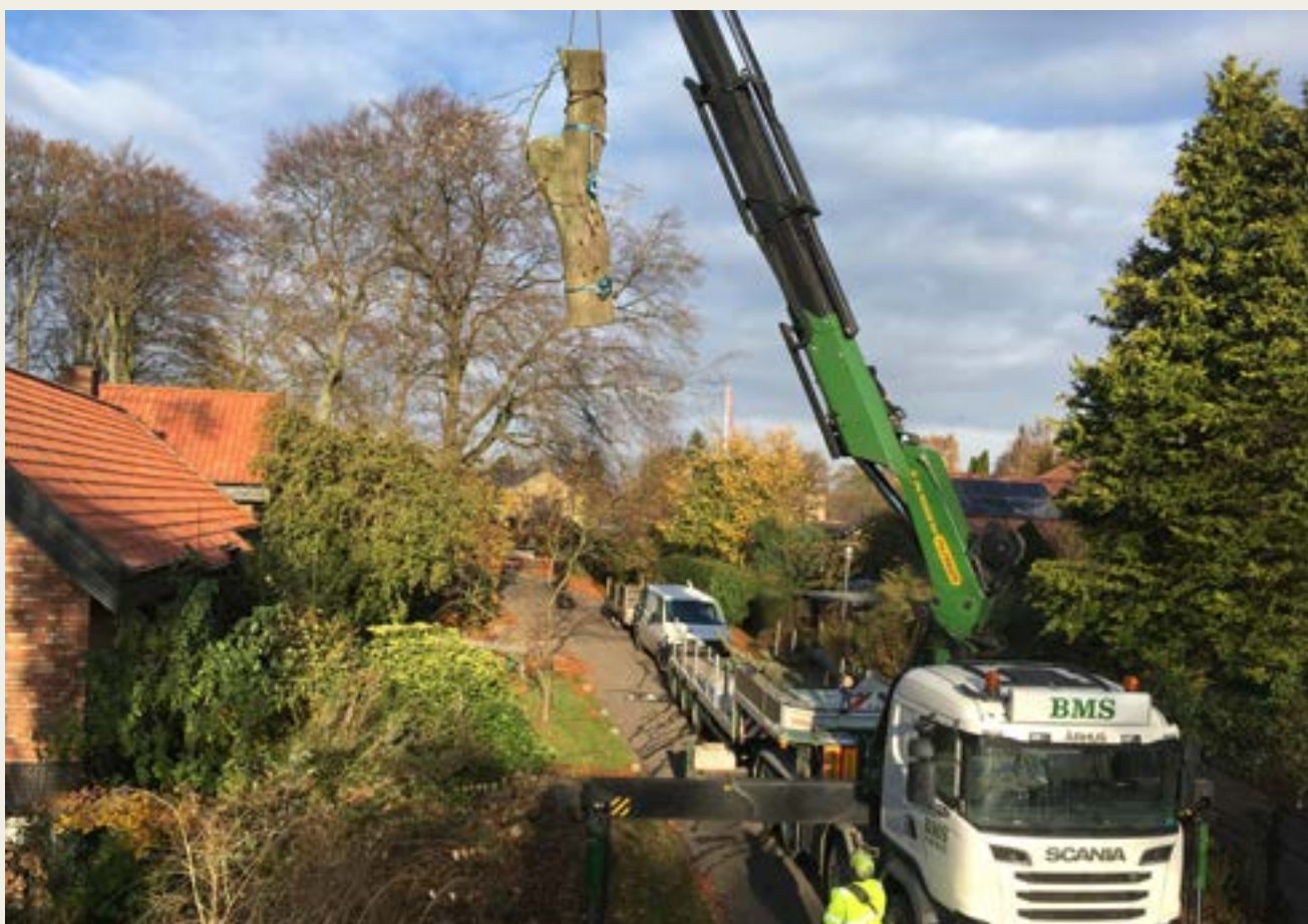
Illustration 1: Stort flækket bøgetræ. Vejen er spærret af og der er etableret omkørsel. Flækket i stammen er fikseret med båndsurringer og sektioner løftes sikkert ned med 110 tonsmeter lastbilkran.
