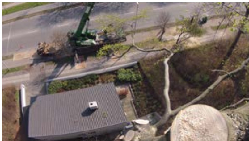
Illustration 5: Kranens støtteben er opstillet på støttebensplader, suppleret med jernplader.
