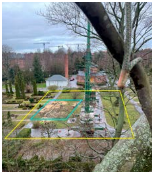
Illustration 2: Sikkerhedszone (gul) og dropzone (blå) er udpeget så alle parter ved, hvorledes projektet kommer til at foregå. Mobilkran er opstillet med støttebensplader på jernkøreplader for at undgå terrænskader. Træet, der fældes, står på en svært tilgængelig skrænt, omgivet af et højt hegn, så her er afspærring ikke nødvendig.
