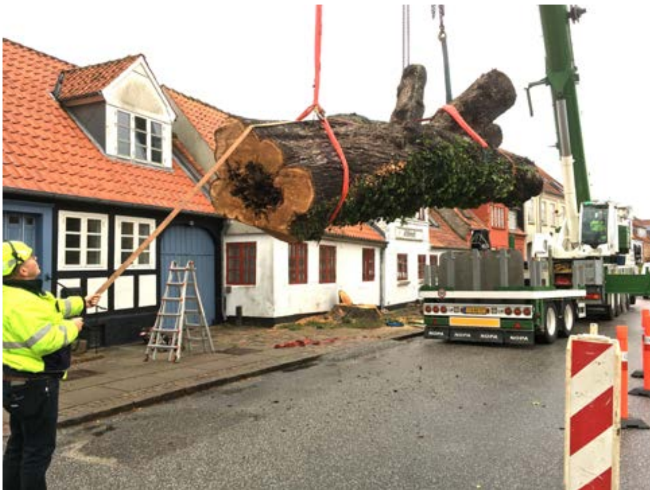
Illustration 15: Brug af styrelin, her i form af en tilpasset spændstrop.
