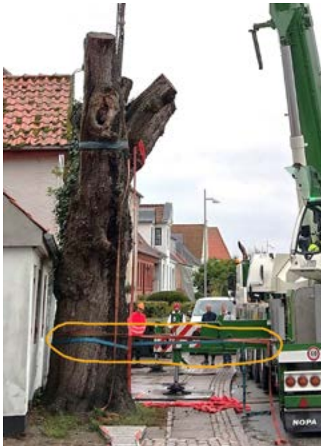
Illustration 6: Bundstykke sikret med båndsurringer inden friskæring, da den store stamme stod med få millimeters afstand til det skrøbelige hus. Selv det mindste udsving kunne ikke tillades. Efter friskæring, blev båndsurringer fjernet, inden kranen løftede stammen.
