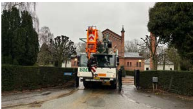
Illustration 6: Det kræver en dygtig kranfører, at køre en stor mobilkran. Her er der udlagt jernkøreplader for at skåne underlaget rundt om det gamle kapel. Det kan være en stor hjælp for kranføreren, hvis en eller flere fra arbejdsholdet hjælper med at holde uvedkommende væk, mens kranen manøvreres ind.
